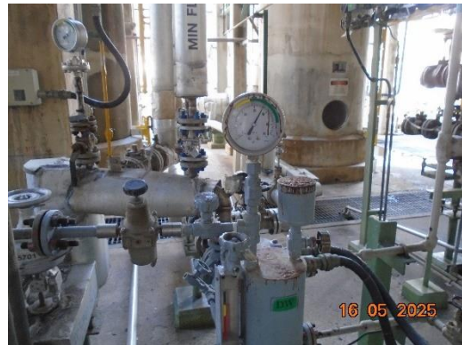
ภาพที่ 2.1-39 เกจวัดอัตราการไหล ความดันและ เทอร์โมมิเตอร์ ที่ท่อขนส่งต้นทาง
