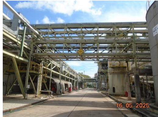
ภาพที่ 2.1-37 ระบบท่อขนส่งที่เป็นระบบปิดและ วางบนฐานรองรับท่อ (Pipe Rack)
