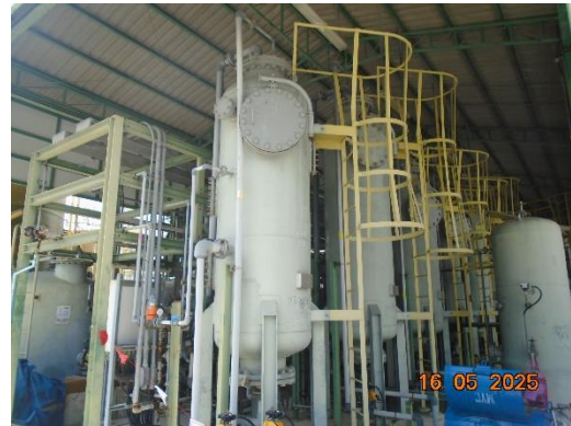
ภาพที่ 2.1-54 ระบบ RO unit
