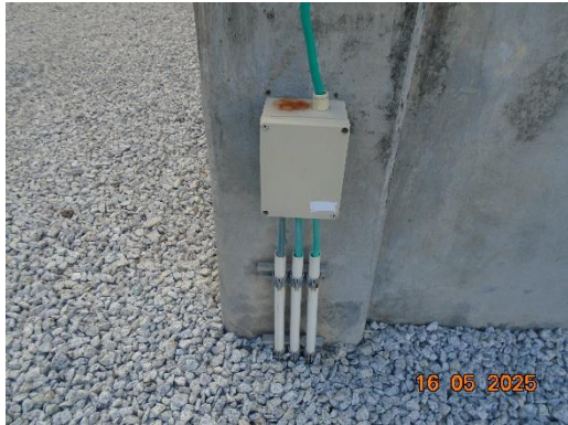
ภาพที่ 2.1-48 ระบบป้องกันฟ้าผ่า
