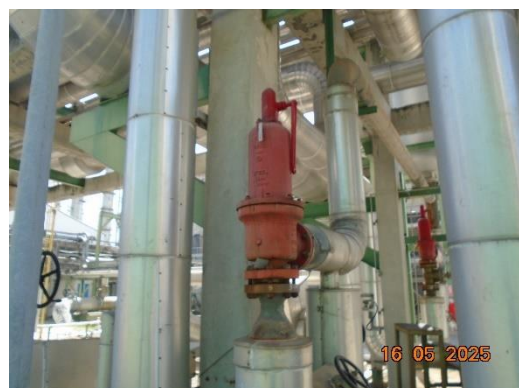
ภาพที่ 2.1-41 Safety Valve บริเวณท่อขนส่ง
