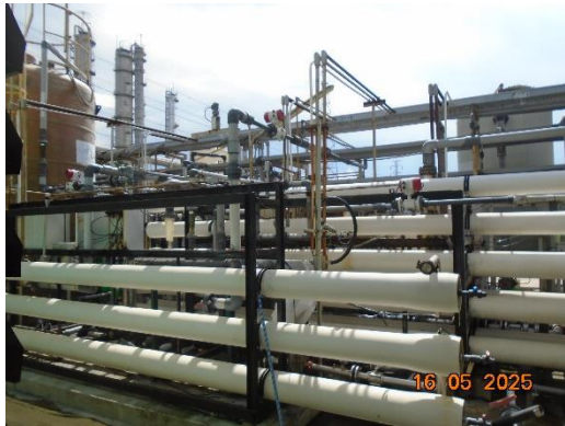
ภาพที่ 2.1-54 ระบบ RO unit
