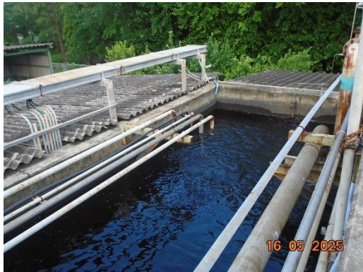
บ่อ Equalization โรงงาน 1
