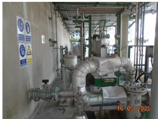
ภาพที่ 2.1-29 ระบบการควบคุมอุณหภูมิในถังเก็บกัก MMA (การติดตั้ง Chiller, Circulation Pump)
